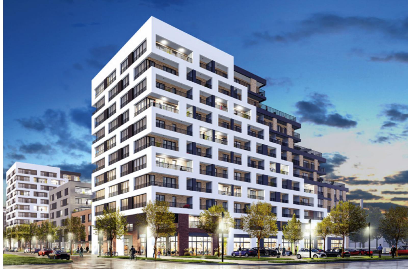
Realizace projektu společnosti CENTRAL GROUP a.s.– Tesla Hloubětín
